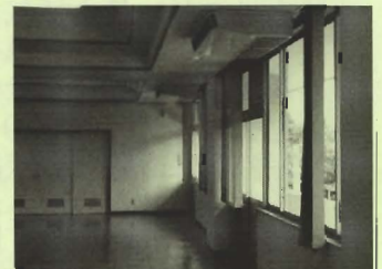
全館空調設備の更新
