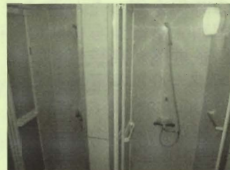
2階シャワー室の改修
